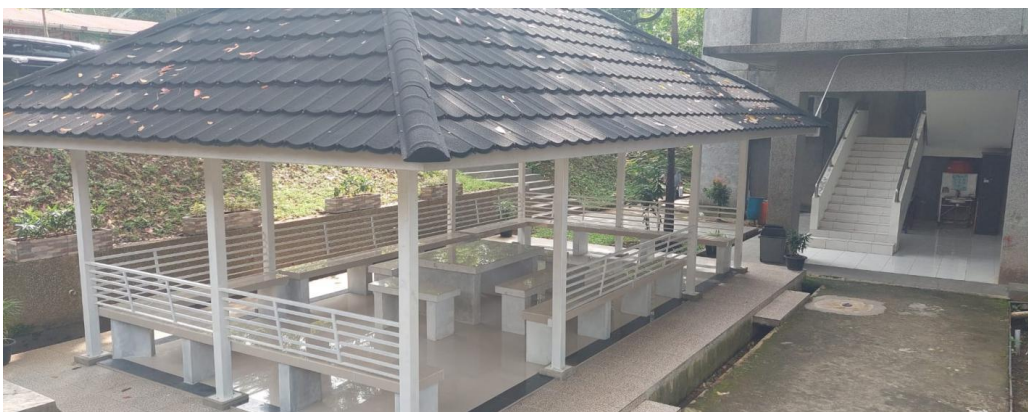
Gambar 3. Pembangunan Gazebo2 FISIP
