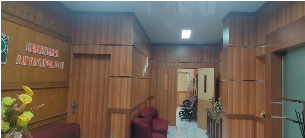
Gambar 4. Rehab Beranda Departemen Antropologi FISIP
