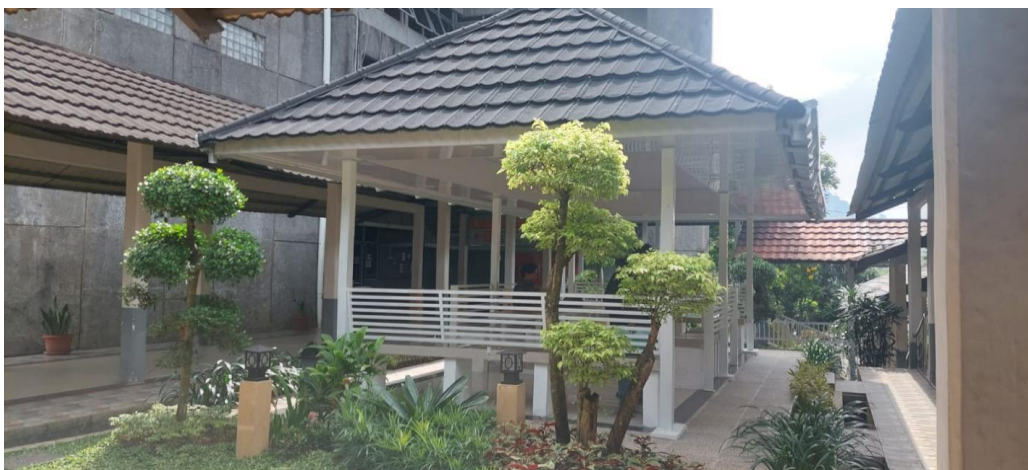
Gambar 2. Pembangunan Gazebo FISIP
